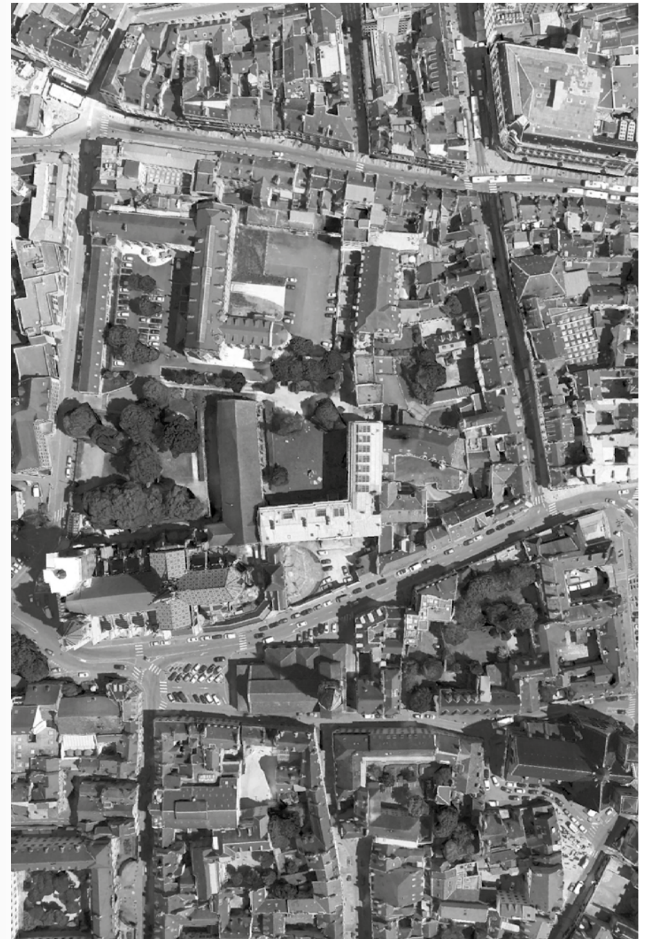
Vue aérienne de l'école
